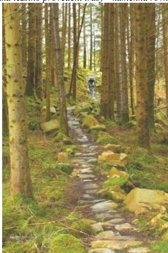
Ukázka těžšího provedení trasy - kamenná rovnánina
